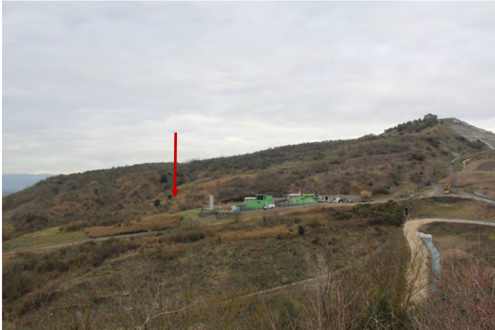
Veduta dall'interno del polo impiantistico
