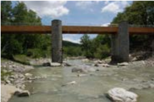
Ponte Cahen ristrutturato nel 2011
